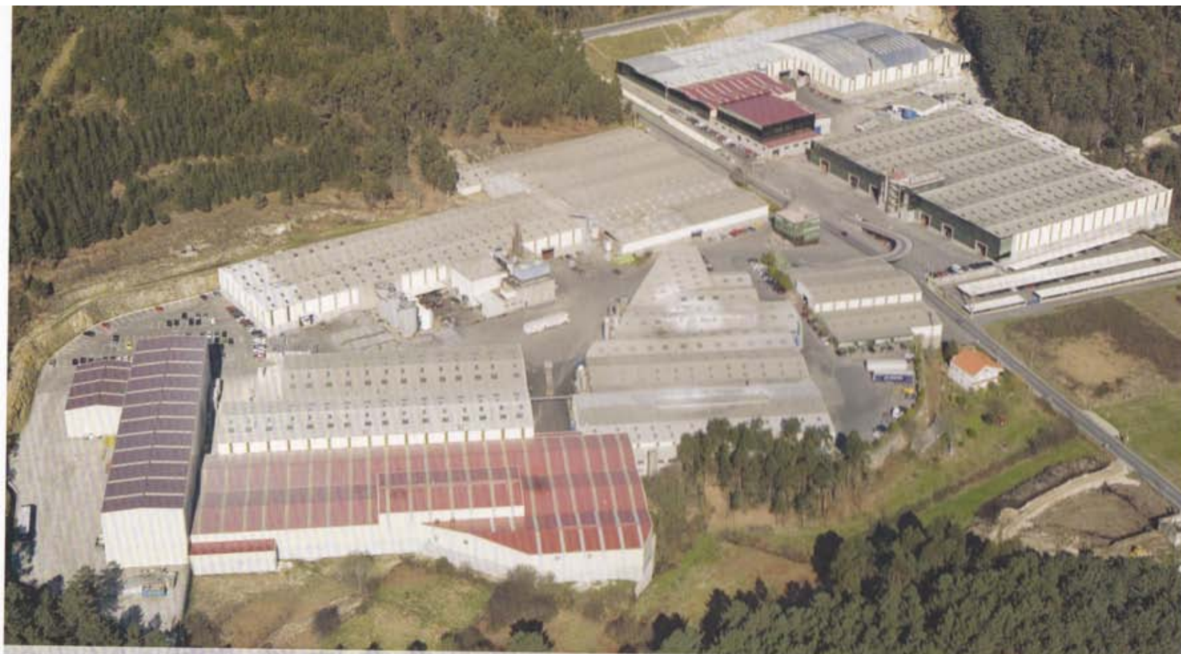
Instalaciones de CORTIZO en Padrón (A Coruña-España)
