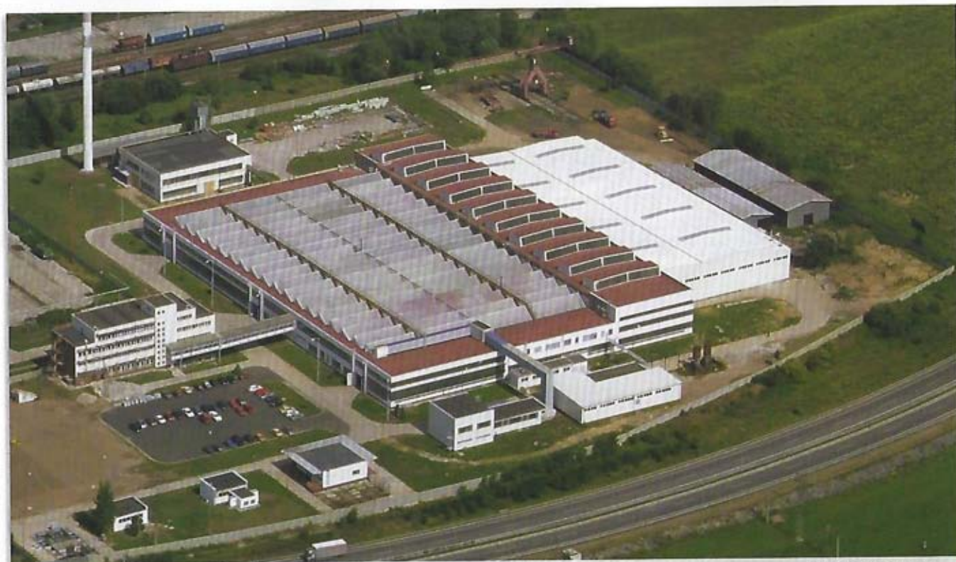
Fábrica y Oficinas Centrales en ESLOVAQUIA
