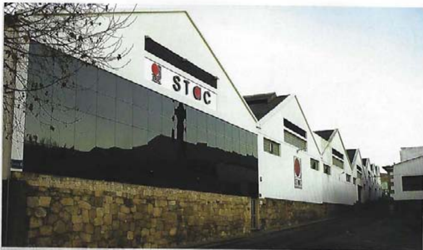
Instalaciones de STAC en Padrón (A Coruña-España)
