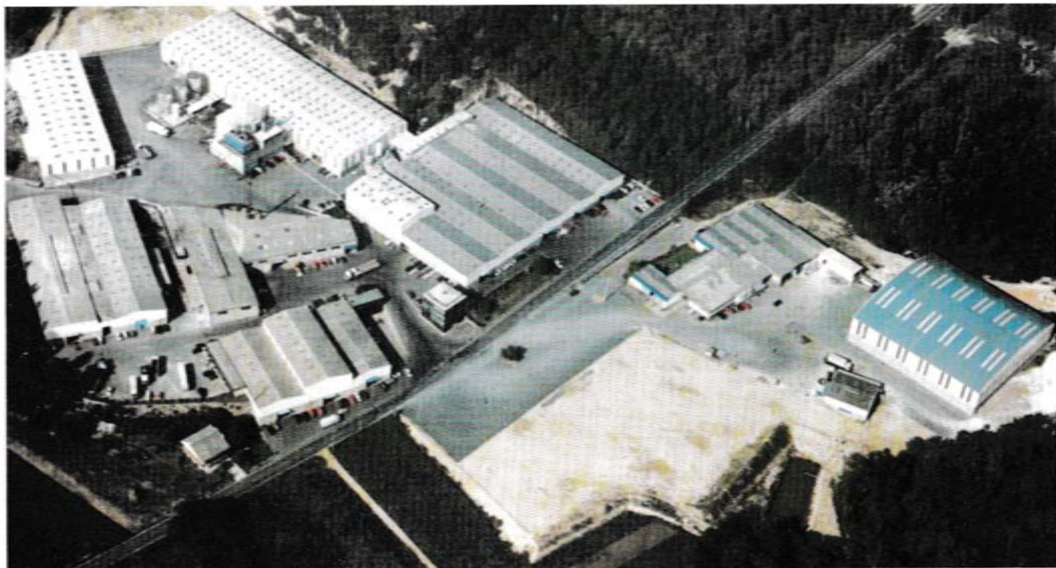
INSTALACIONES DE ALUMINIOS CORTIZO EN PADRÓN (LA CORUÑA)
