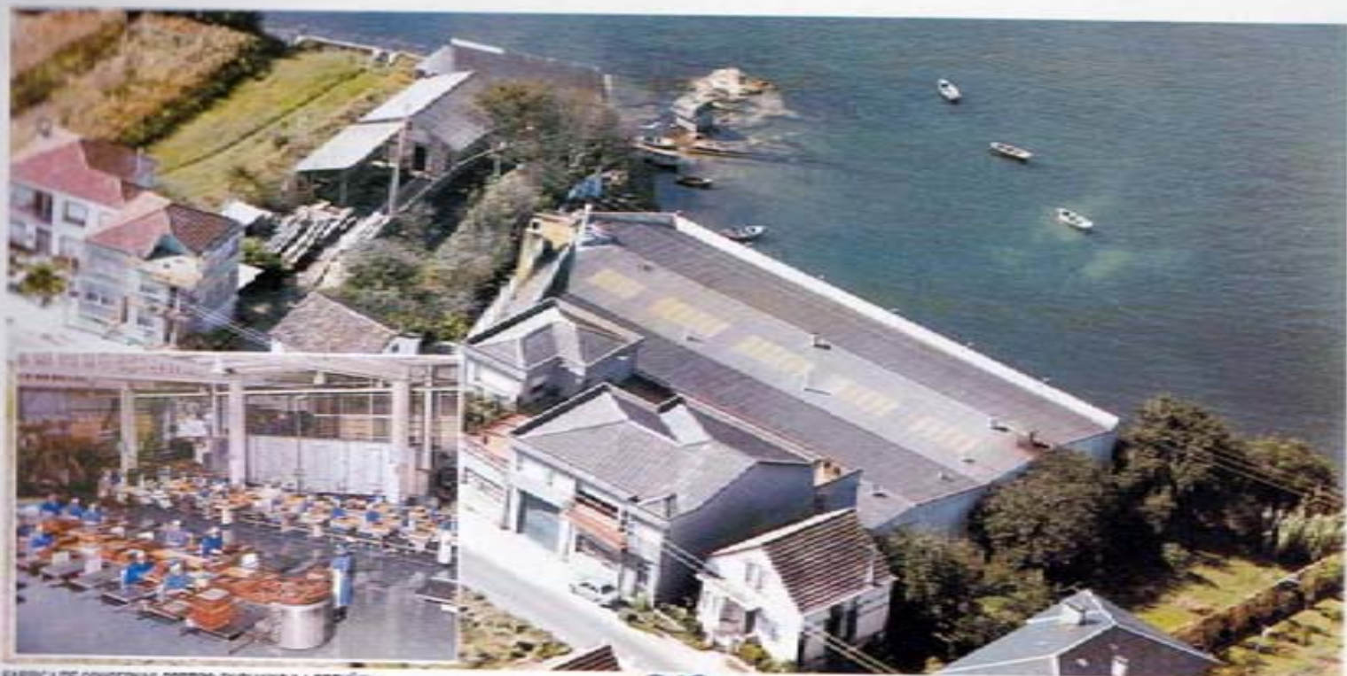
FABRICA DE CONSERVAS CORTIZO ENRIAXIO (LA CORUÑA)
