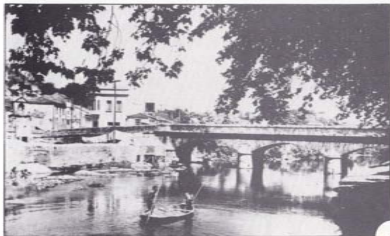
Puente sobre el Río Sar.
