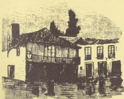
AS INUNDACIONES DE PADRON NO 1.880 NA PLAZA DO FIADO (Macías)
